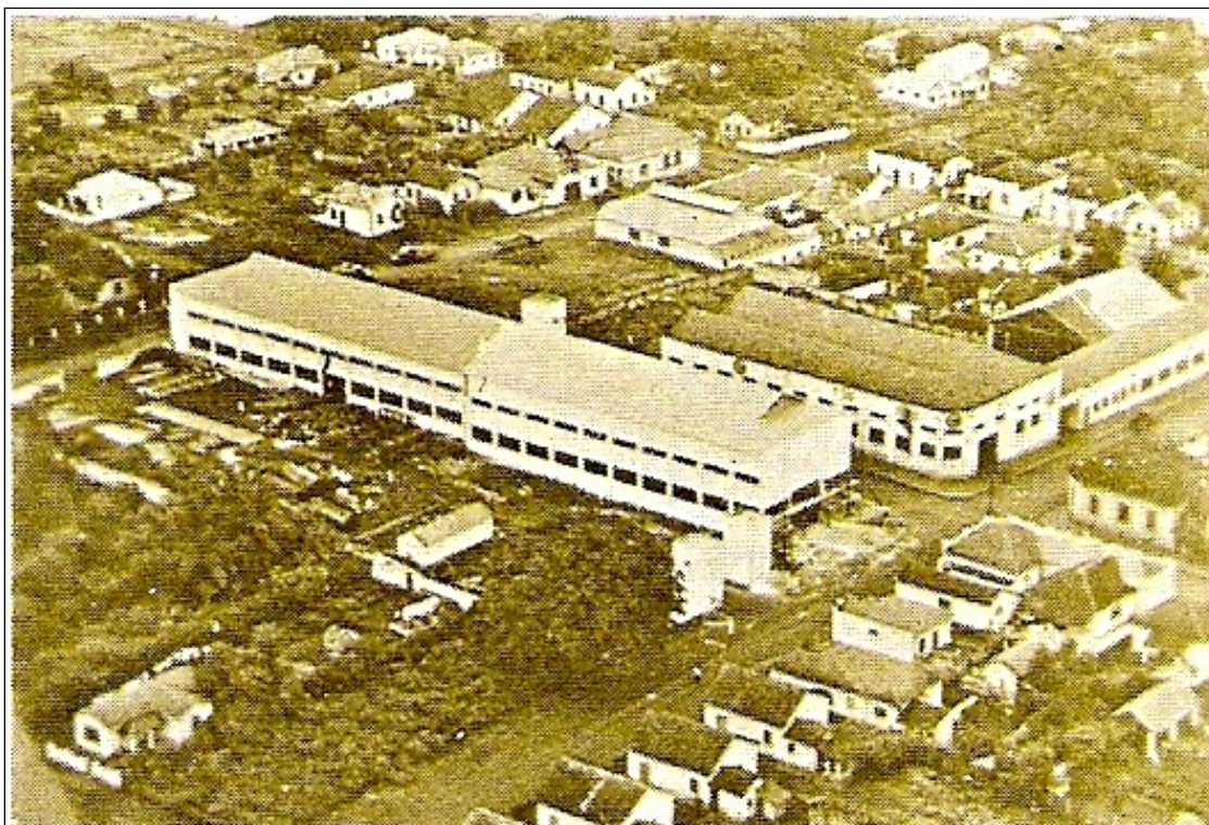
Vista aérea da primeira instalação da Zanini
